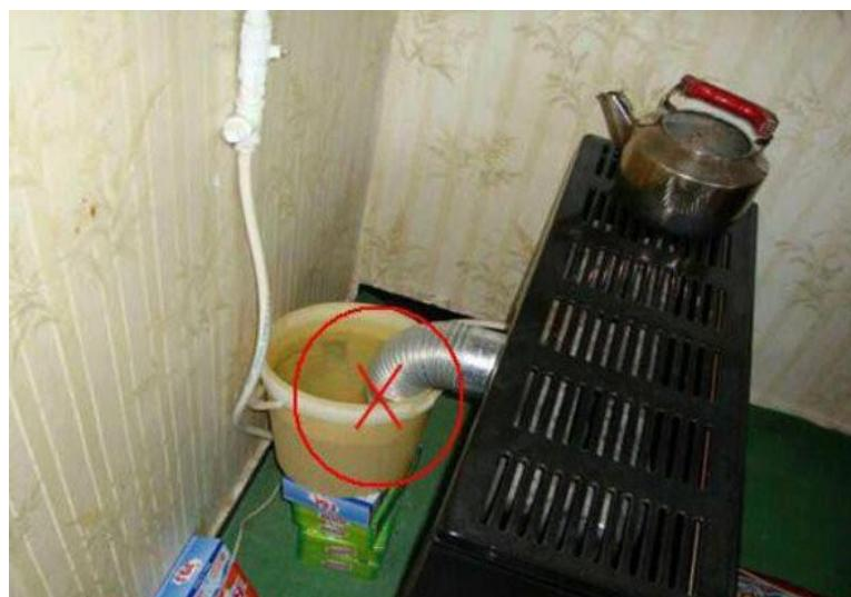
استفاده از بخاری بدون اتصال دودکش آن یا قرار دادن دودکش در ظرف آب به معنی مرگ است! به هیچ عنوان چنین کاری انجام ندهید. لوله دودکش باید به طور کامل به خارج از خانه و به هوای آزاد هدایت شود تا دود حاصل از احتراق وسایل گازسوز به کلی از محل خارج شود.
